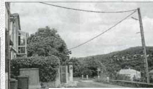
Six poteaux ont été
