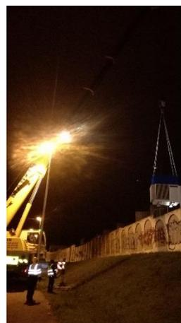
Un préalable à ces travaux a été le remplacement d'une impédance de compensation au poste de 4 seigneurs (impédance 600A remplacée par 1000A). Ces travaux ont dû être effectués de nuit à partir du domaine public.
