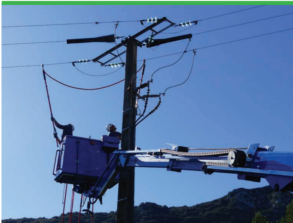
Pose de dispositifs Avifaune à Liausson
