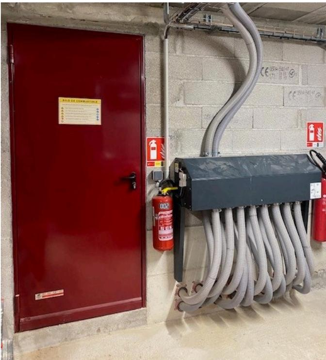
Entrée du silo de stockage avec système d'aspiration pour acheminer les granulés de bois jusqu'à la chaudière.
