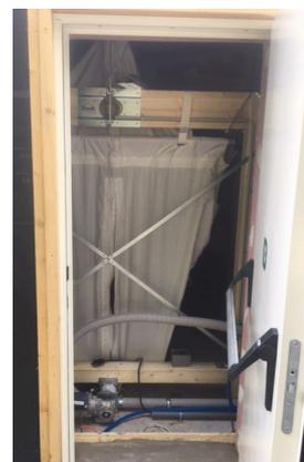
**Installation du silo géotextile dans la pièce de réserve.**
