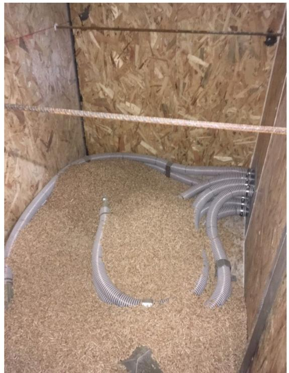
Système d'aspiration pour acheminer les granulés jusqu'à la chaudière.
