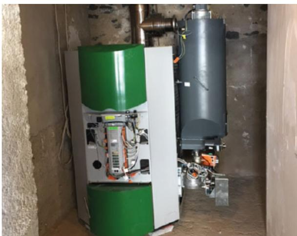
Pose de la chaudière bois et mise en conformité du local chaufferie.
