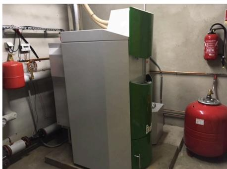
Pose de la chaudière bois et mise en conformité du local chaufferie.
