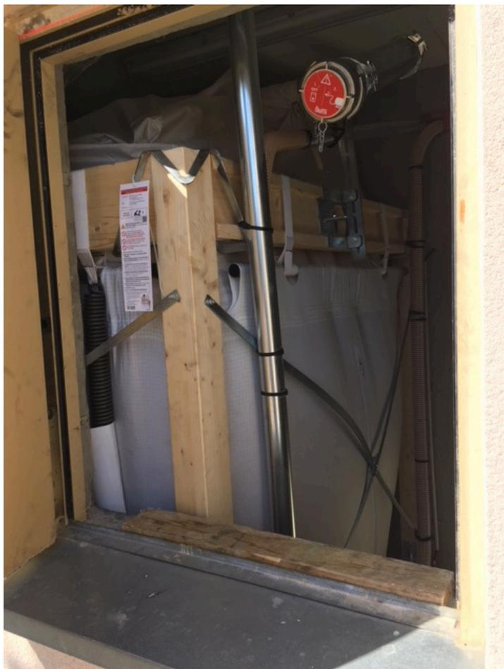
Silo géotextile et tube de remplissage.
