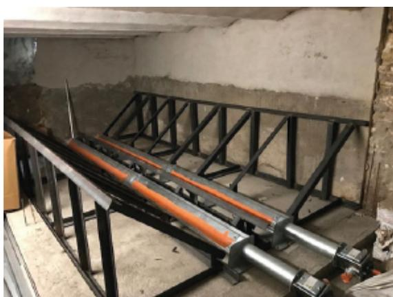
4. installation des vis sans fin permettant l'acheminement des granulés jusqu'à la chaudière.
