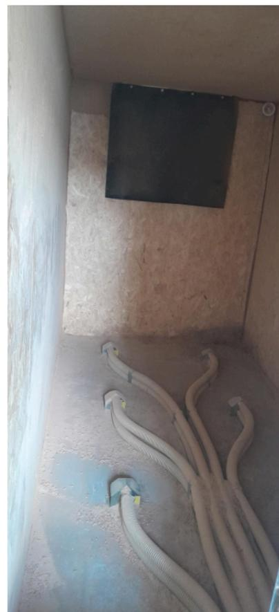
Intérieur du silo de stockage avec système d'aspiration des granulés.
